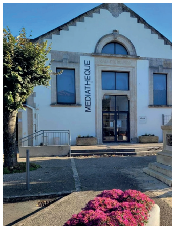
Aménagement extérieur de la médiathèque "Léode" de Chaillé-les-Marais
